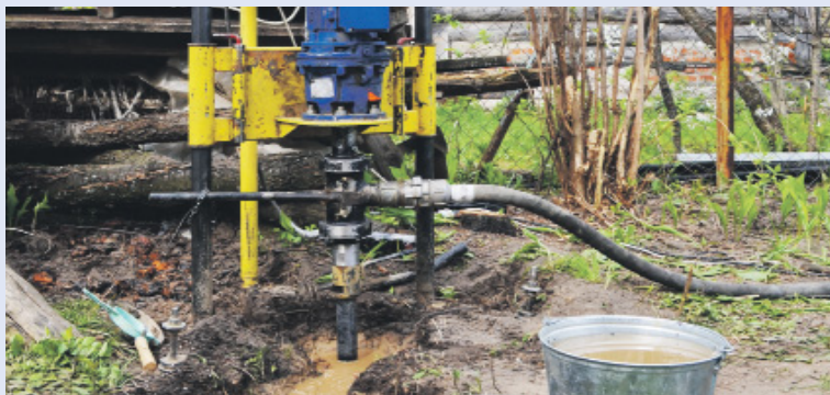
▲ Бурение скважины для водоснабжения
